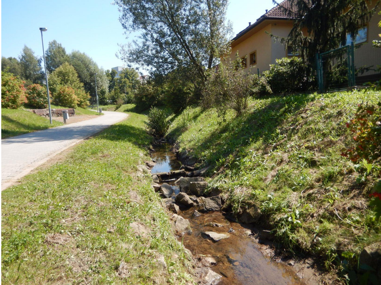
Obr. 12: Hrázky na vodním toku s omezenou prostorovou možností revitalizace (Zdroj: AOPK ČR)
