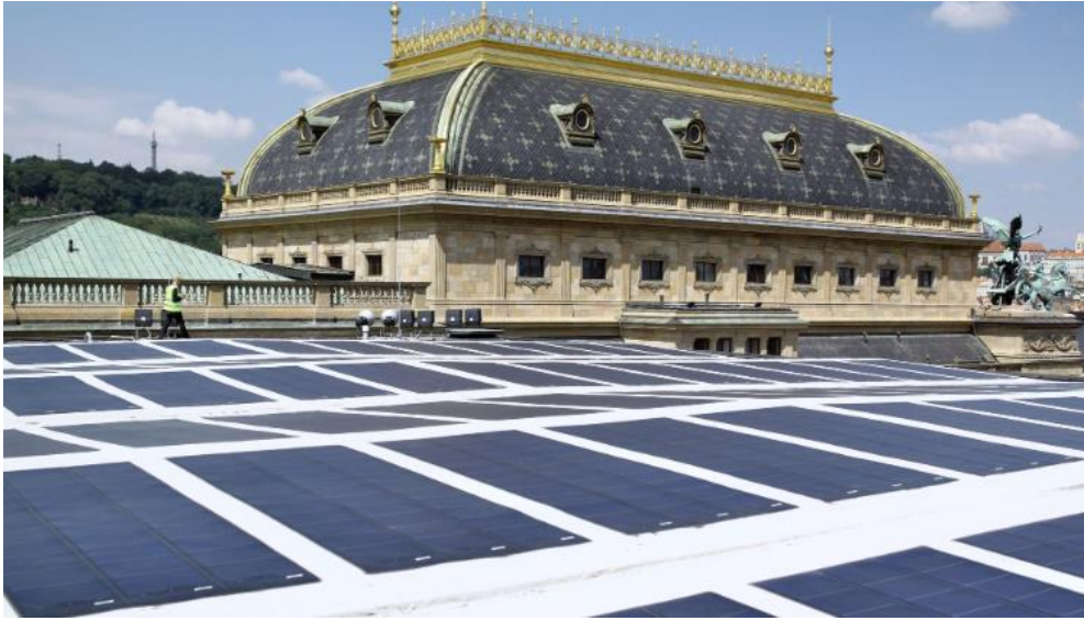
Foto: Národní divadlo, Nová scéna (střešní krytina), Zdroj: Ivan Baroch Obnovitelně.cz
