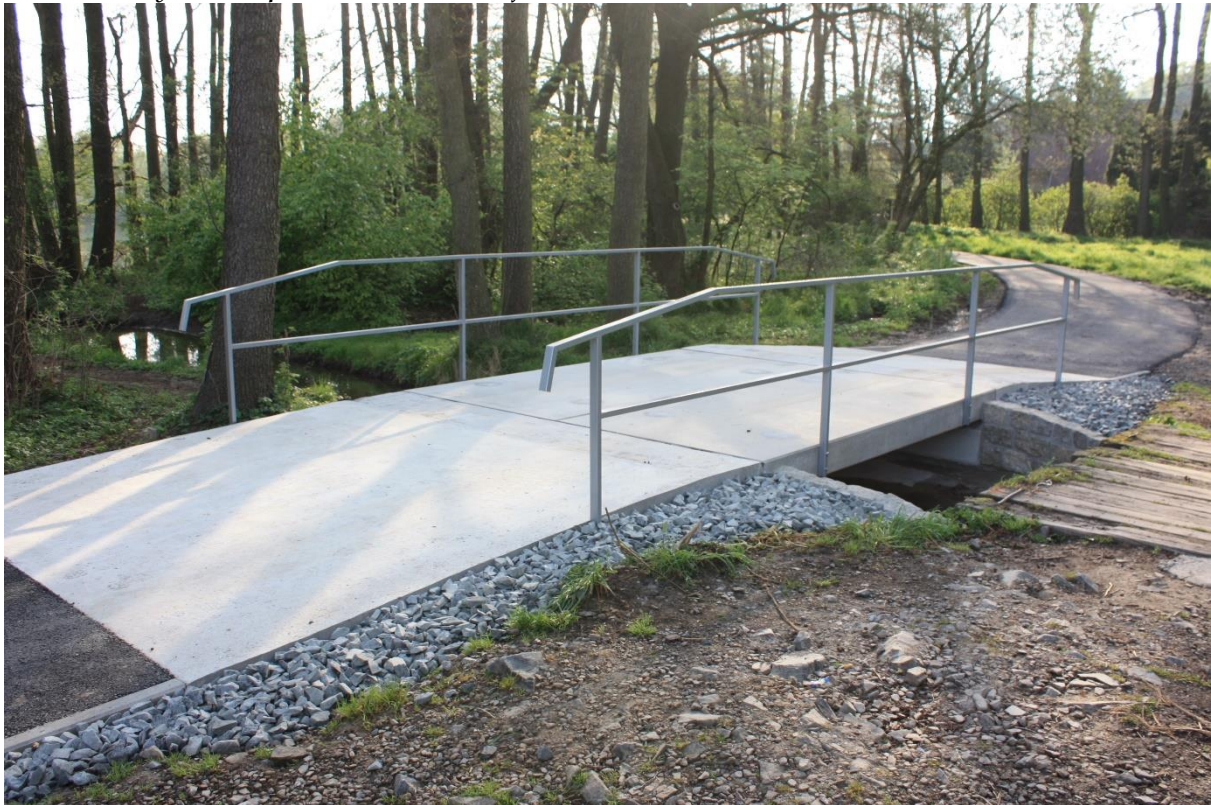
Obr. 13: Nový můstek přes vodní tok (Zdroj: Miroslav Šmíd)
